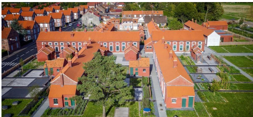
Réhabilitation de la Cité des électriciens à Bruay-la-Bussière (62)
