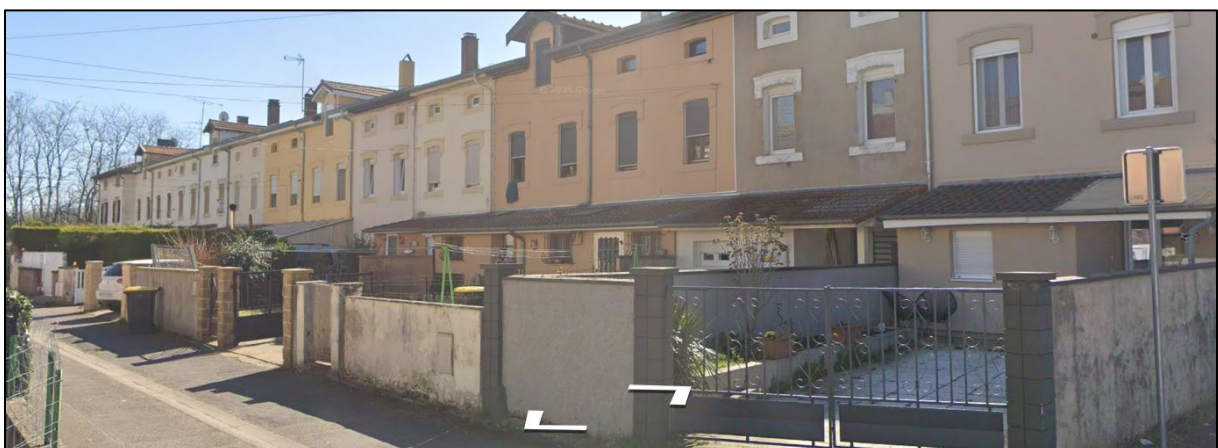
Maisons ouvrières de la cité Saint-Paul, allée George Guynemer : vue sur l'avant des constructions (source : Google streetview)
